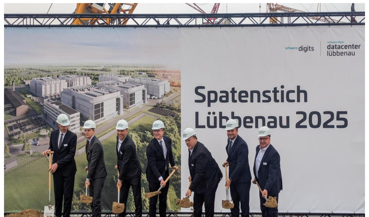
Строительство ЦОД Schwarz Digits, Люббенау, Германия
