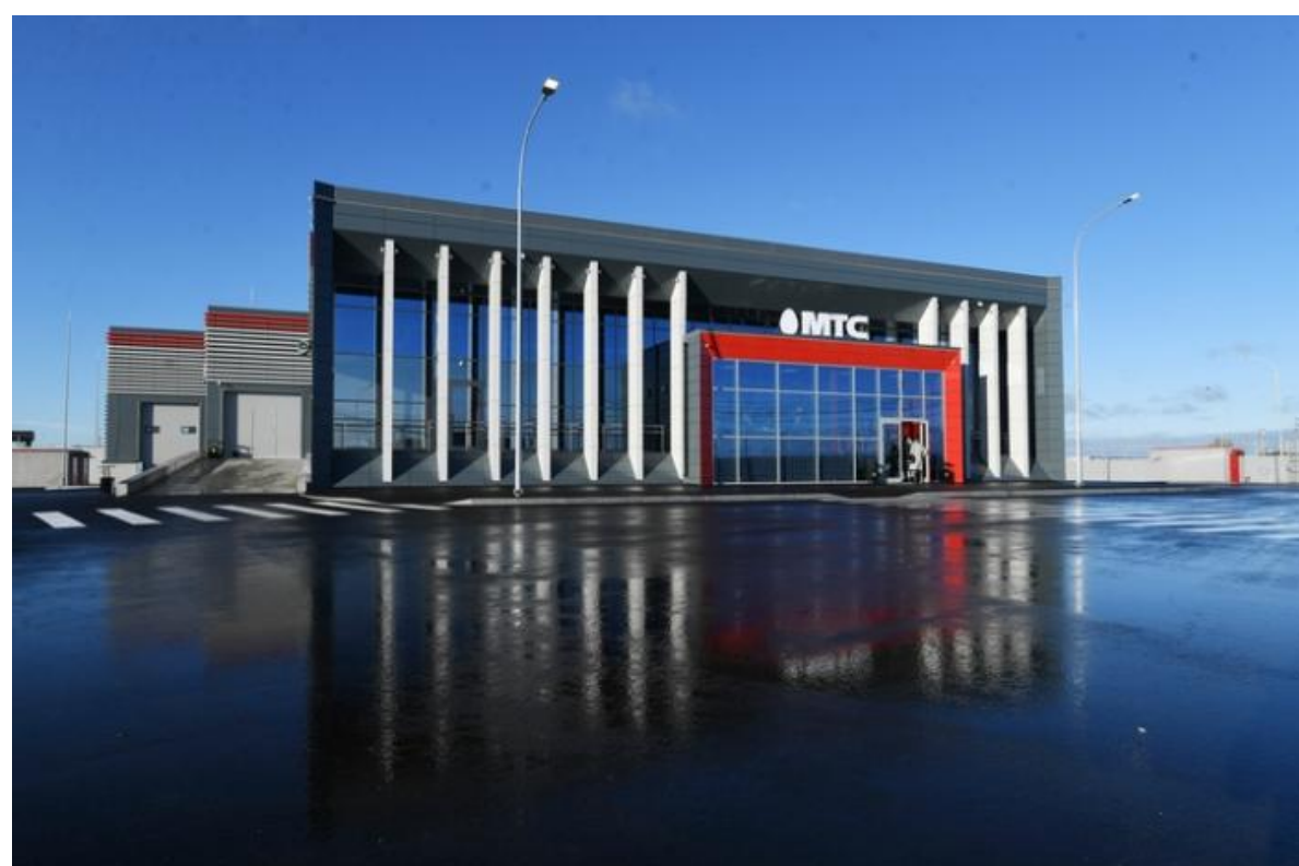
ЦОД МТС, пос. Федоровское Тосненского района Ленинградской области
